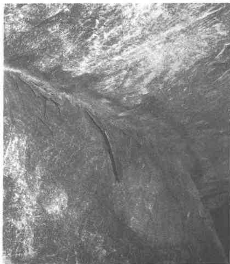
图 2-1 应变型岩爆典型破坏
